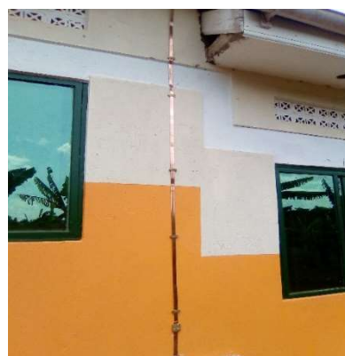
Installation der Blitzableiter
