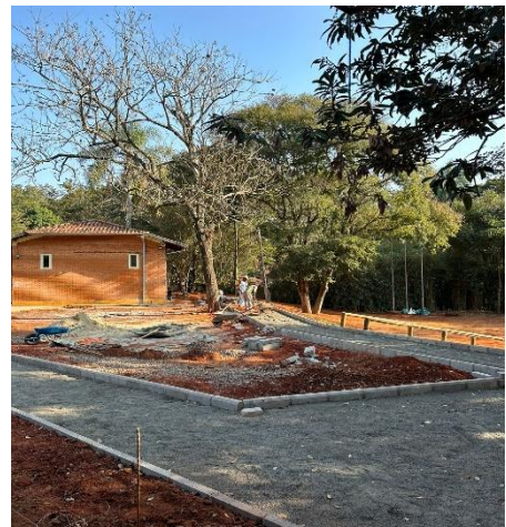
Der Boden des Schulgeländes wird für die Erdarbeiten vorbereitet.
