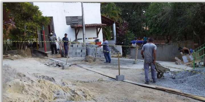
Sanierungsmaßnahmen an der Escola de Resiliência
