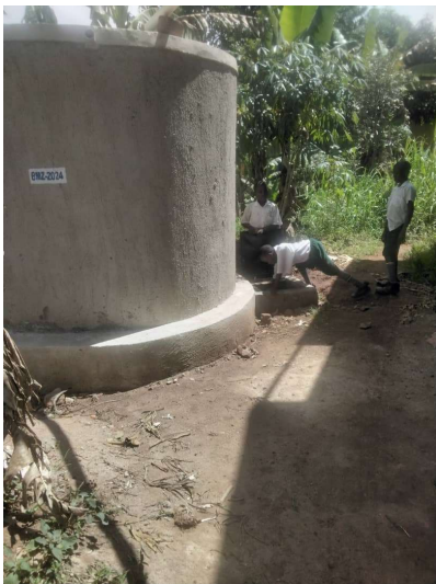
Einer der Wassertanks, die auf dem Schulgelände errichtet wurden
